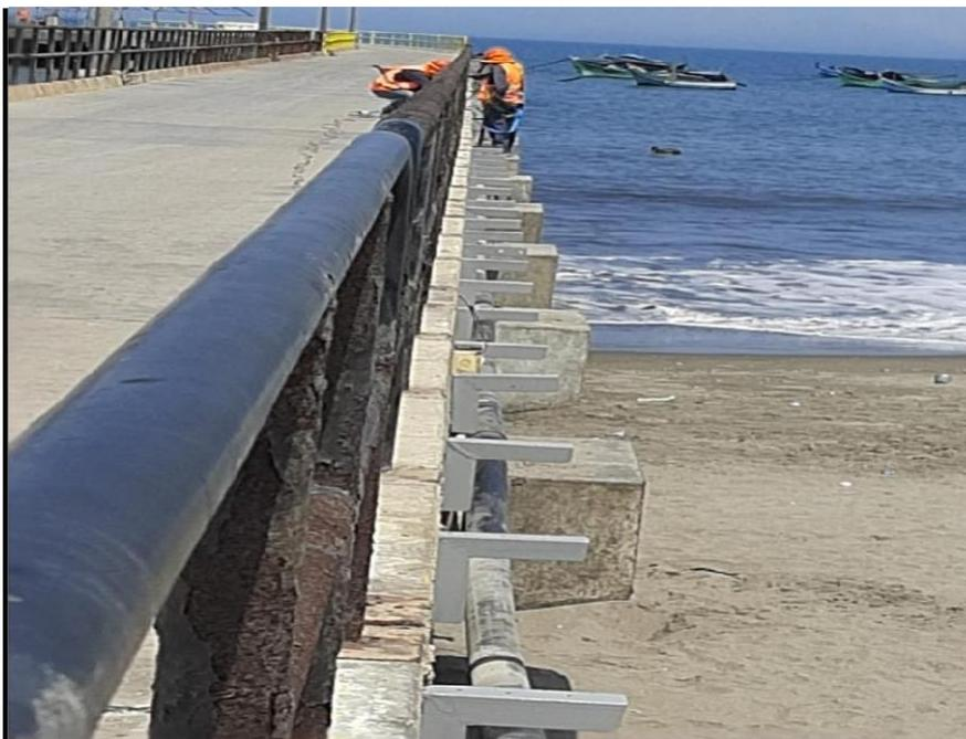
**FOTO N°04.-** SE APRECIA COLOCADO DE SOPORTES CON ANGULO GALBANIZADO EN LADO DERECHO
