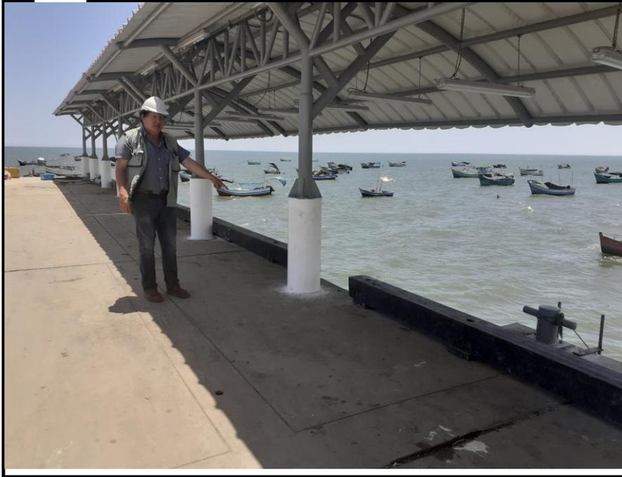
**FOTO N° 13.- SE APRECIA EL PINTADO DE LOS PEDESTALES**
