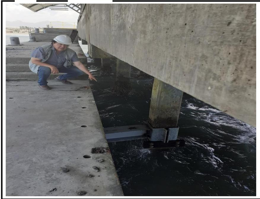
**FOTO N° 17.- SE APRECIA ABRAZADERA TOPE Y VIGA DE ARRIOSTRE EN PLATAFORMA N°01**
