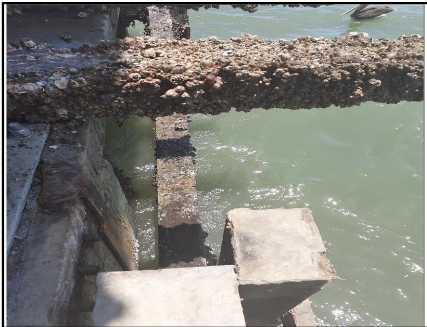
**FOTO N° 18.- SE APRECIA EL DESMONTAJE DE PARANTES EXISTENTES QUE SE ENCUENTRAN EN MAL ESTADO**
