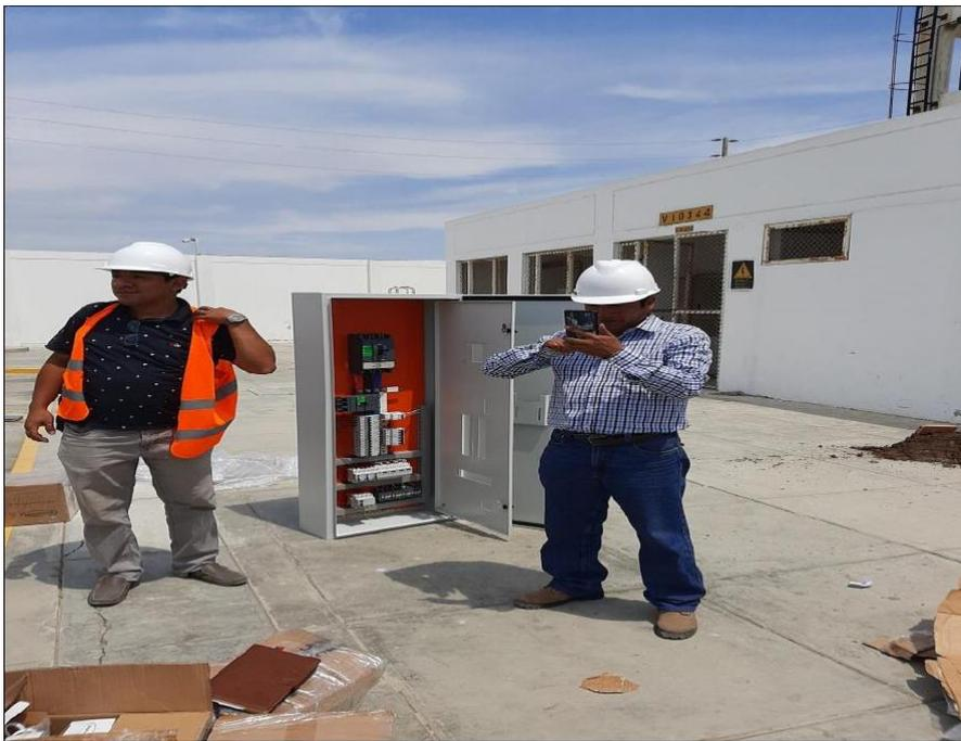
**FOTO N° 12.-** SE VERIFICA EL TABLERO GENERAL ANTES DE SER COLOCADO
