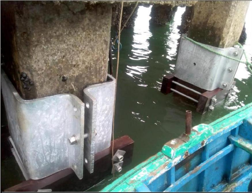
**FOTO N° 16.- SE APRECIA LA INSTALACION DE ABRAZADERAS CON SUS RESPECTIVOS TOPES**
