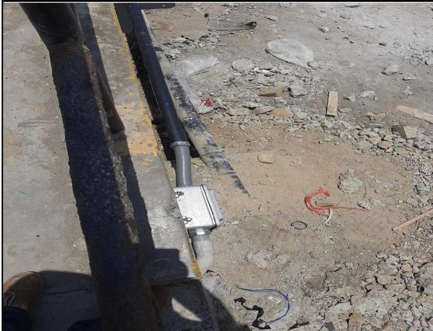
**FOTO N° 11.-** SE APRECIA EL TENDIDO DE LA TUBERIA CONDUIT Y LA CAJA DE PASE COLOCADA CORRECTAMENTE
