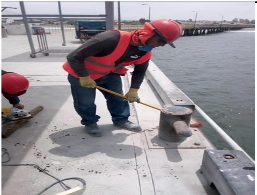
**FOTO N°02.-** SE APRECIA EL MANTENIMIENTO DE BITAS DE LADO DERECHO DE CABEZO DE MUELLE DPA PTO MORIN
