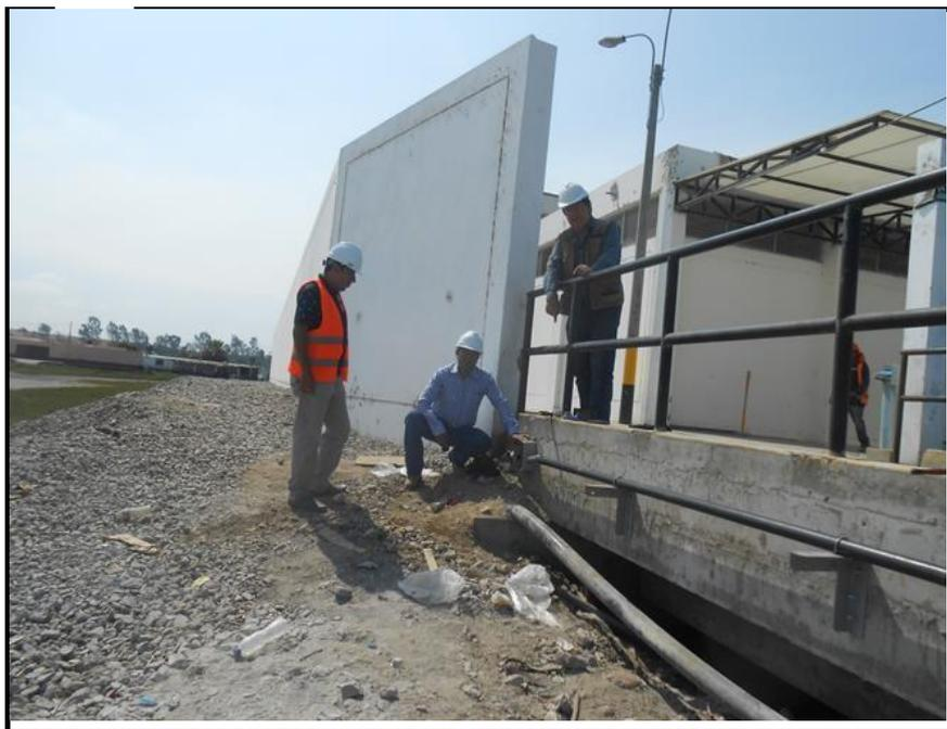
**FOTO N°09.-** SE APRECIA EL COLOCADO DE TUBERIA CONDUIT HACIA EL CABEZO SUPERVISADO POR LOS ESPECIALISTAS ELECTRICOS DEL CONTRATISTA Y LA SUPERVISION
