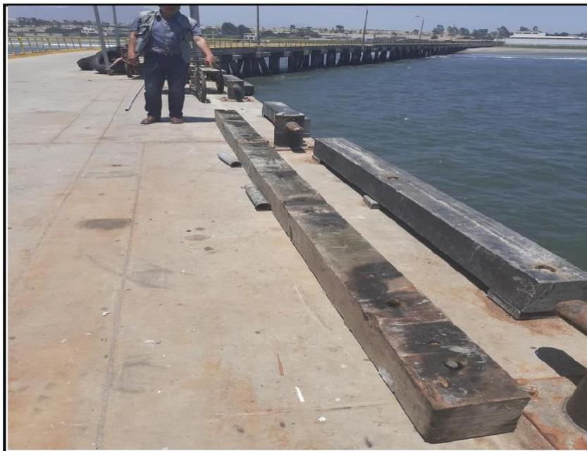
**FOTO N° 20.-** SE APRECIA LA VIGA DE ARRIOSTRE DESMONTADA A CAMBIAR
