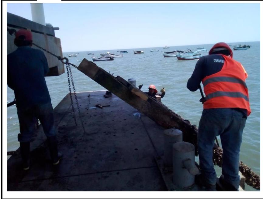
**FOTO N° 23.- SE APRECIA DESMONTAJE DE PARANTES DE SISTEMA EXISTENTE DE PROTECCION EN AREA DE PLATAFORMA 01**
