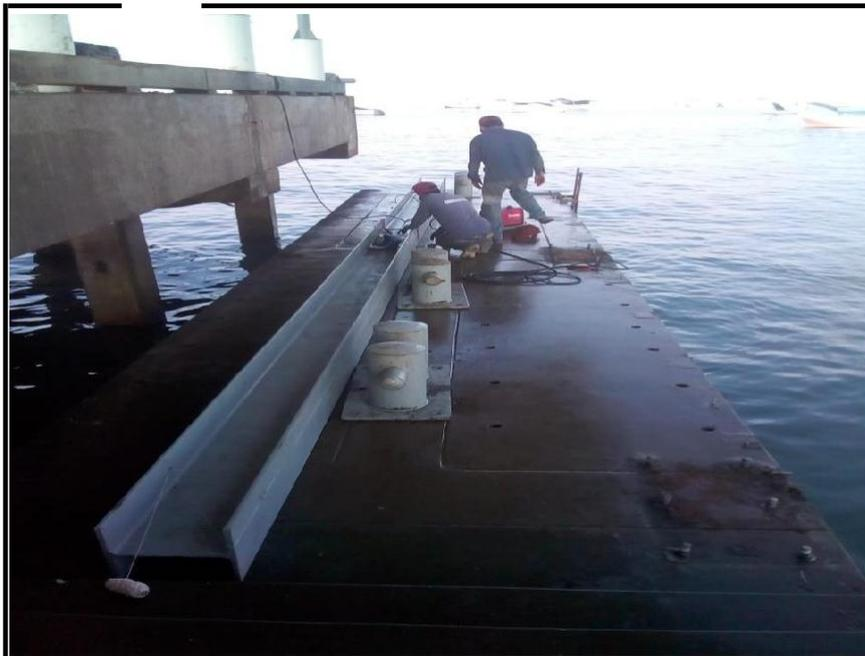
**FOTO N° 24.- SE LA VIGA METALICA A SER COLOCADA EN LA PARTE POSTERIOR COMO ARRIOSTRE EN LA PLATAFORMA N 01**
